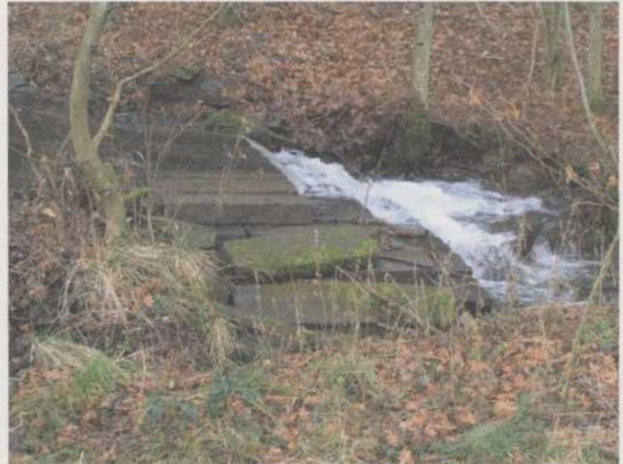
Bild 2 und 3: Kleiner Sohlabsturz unterhalb eines Brückenbauwerks
